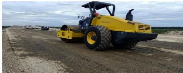
Gambar 2: Alat berat vibrator roller (Jalan Tol Binjai Langsa, 2021)
